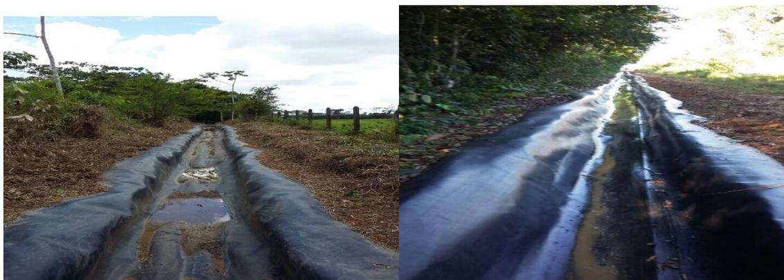
Cuenta con filtro francés para gases, el manejo y tratamiento de lixiviados es de recirculación con suelo impermeabilizado.
