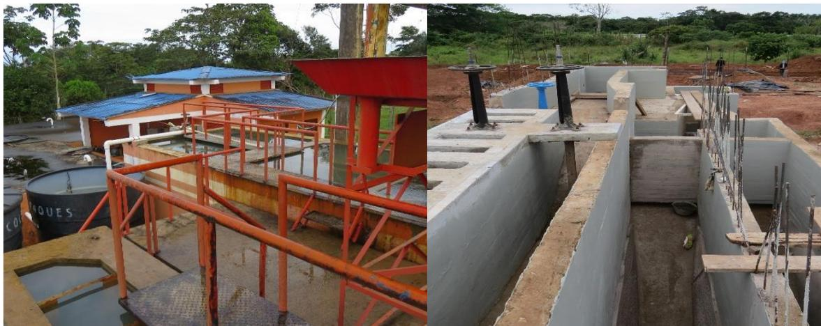
Caudal medio de la fuente, 21 L/seg para el río y 21 L/seg en el pozo. Cantidad de agua facturada al mes 29,34 m<sup>3</sup>. La planta cuenta con un sistema de macro medición, laboratorio y se realiza análisis físico-químico y microbiológicos en laboratorio externo con la empresa ALFAMPAR SAS. Actualmente se construye la nueva PTAP.
